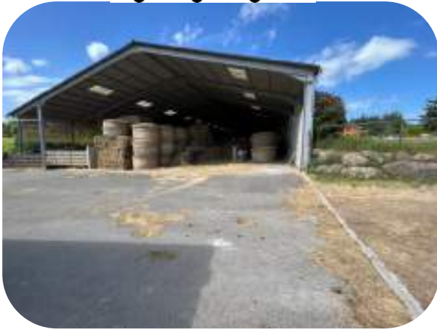
Bâtiment de stockage du fourrage
