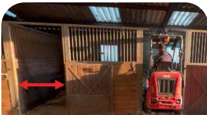
Ouverture partielle de la façade du box
