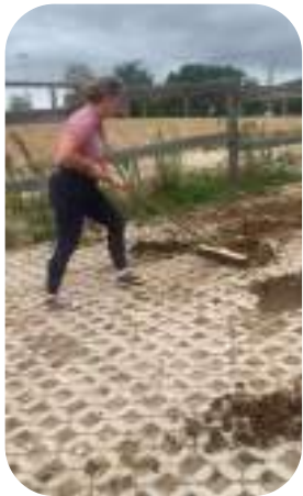
Dalle stabilisée : possibilité de faire des tas sans dégrader le sol
