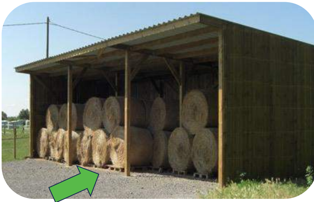
Bâtiment de stockage du foin
