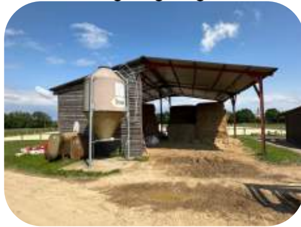
Bâtiment de stockage du fourrage
